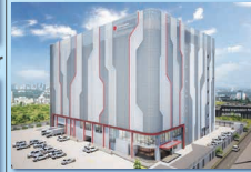
Terra Data Center
